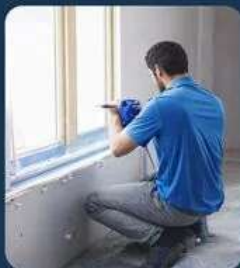
1. Forberedelse og installasjon
